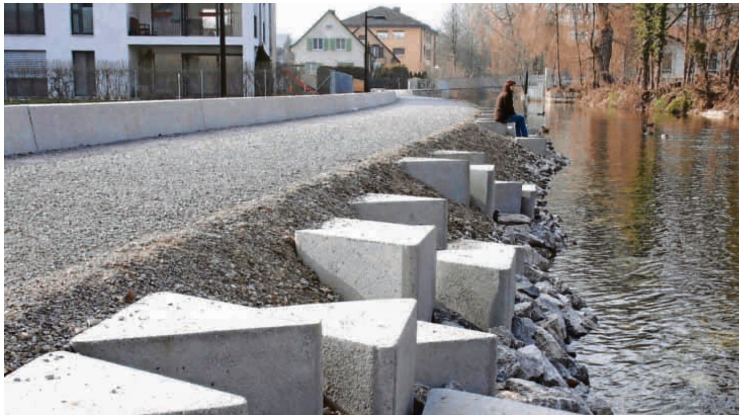
Mit der Neugestaltung konnte das Abflussvermögen des Aabachs im Bereich des Ustermer Stadtparks massiv erhöht und die Umgebung für Erholungsuchende – das Bild stammt aus dem Jahr 2011 – gestaltet werden.
